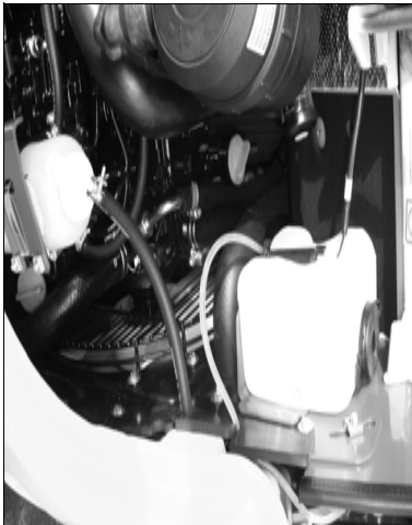
Fig. 67: Beholder til sprinkleranlæg
